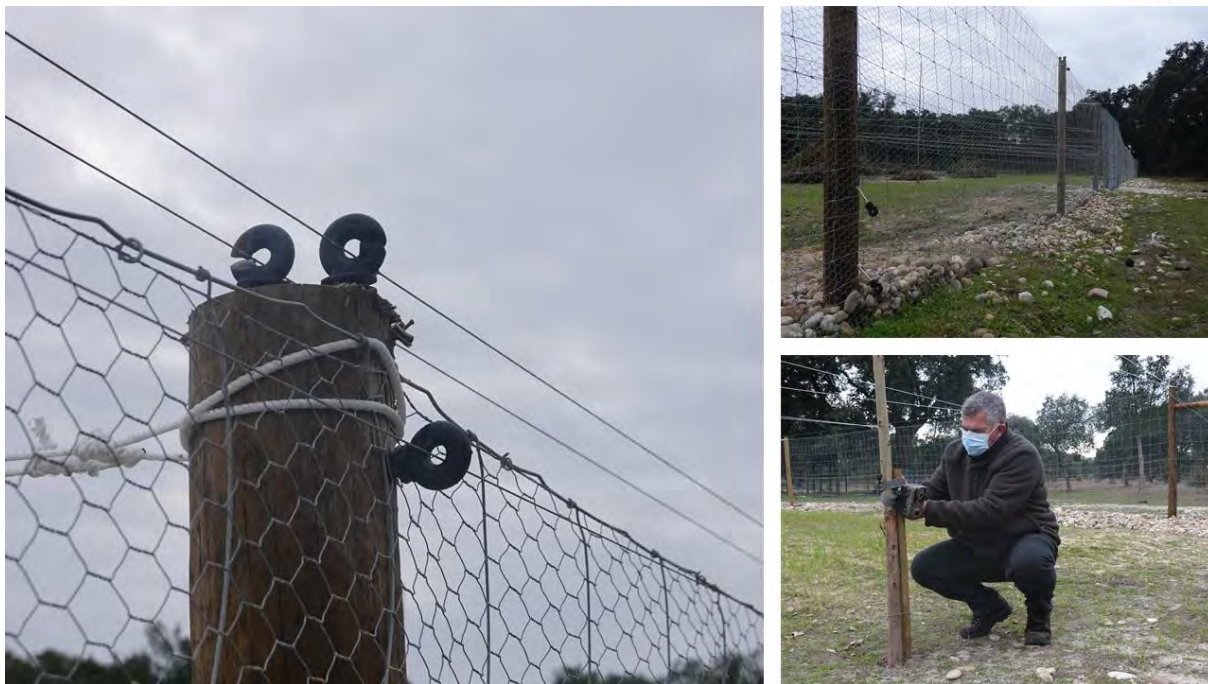
Figura 112. Cerca elétrica para proteção contra predadores e monitorização do cercado construído pela ANPC na Companhia das Lezírias.
