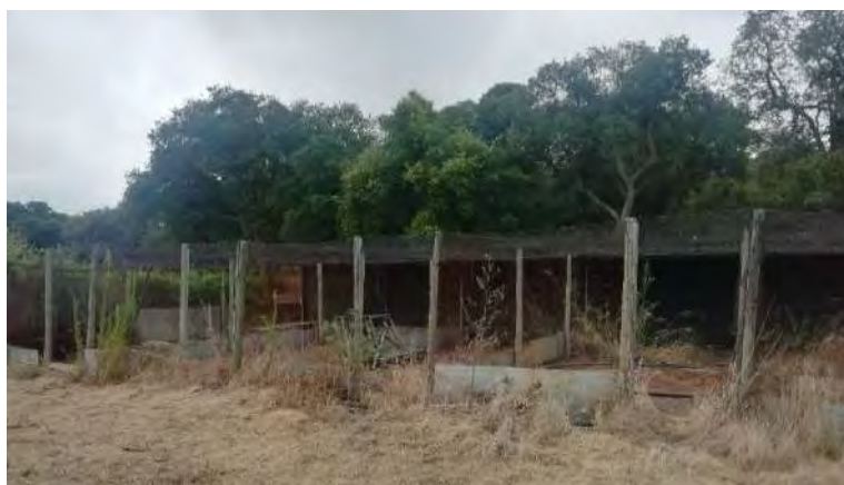
Instalações antes das intervenções. Vista frontal (em cima) e lateral (em baixo). Fotografias de 6 de agosto de 2019.
