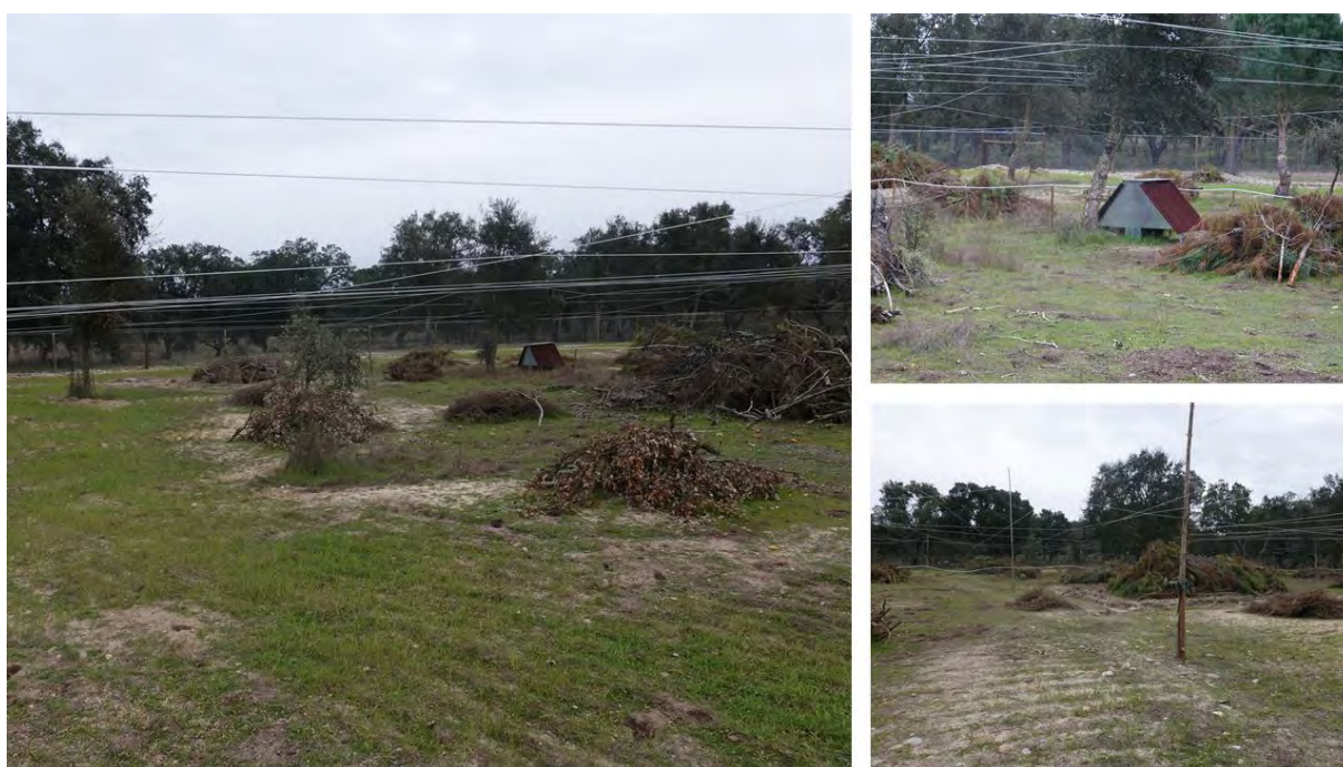
Figura 111. Vista geral do cercado construído pela ANPC na Companhia das Lezírias.
