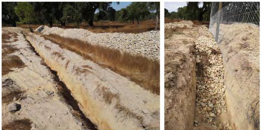
Vala perimetral e enrocamento
